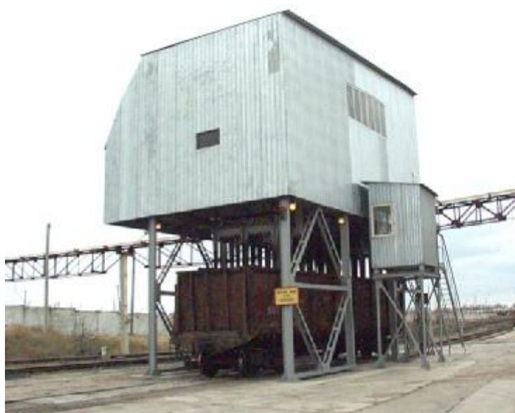
Рис. 1. Общий вид виброрыхлительной установки в Одесском торговом порту «Южный»
