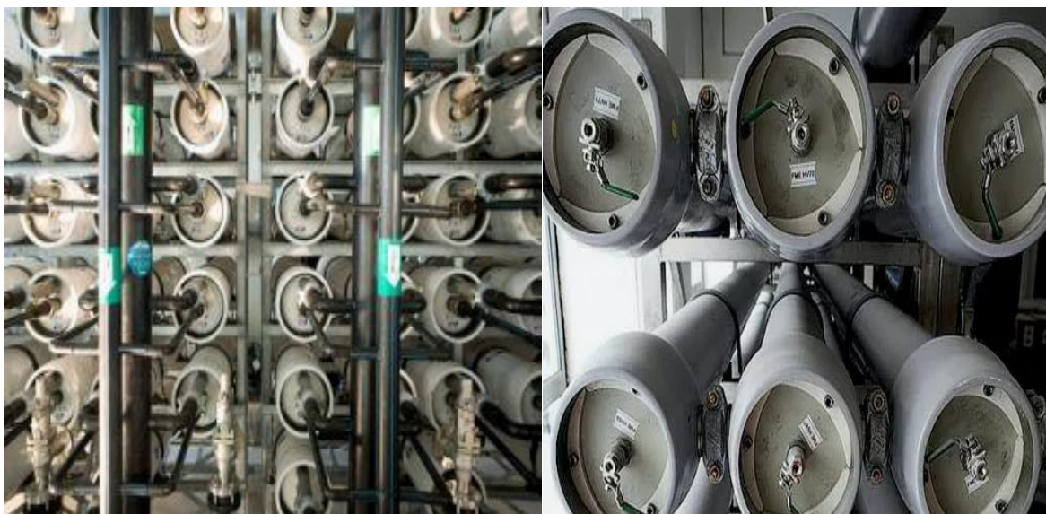
Рисунок 2.79 – Скоченні в довгий рулон та укладені в циліндричні корпуси мембрани
